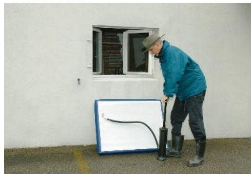
Un proprietario di casa predispone il Floodstop con doppia pompa a pistone per montarlo sulla finestra della cantina.
